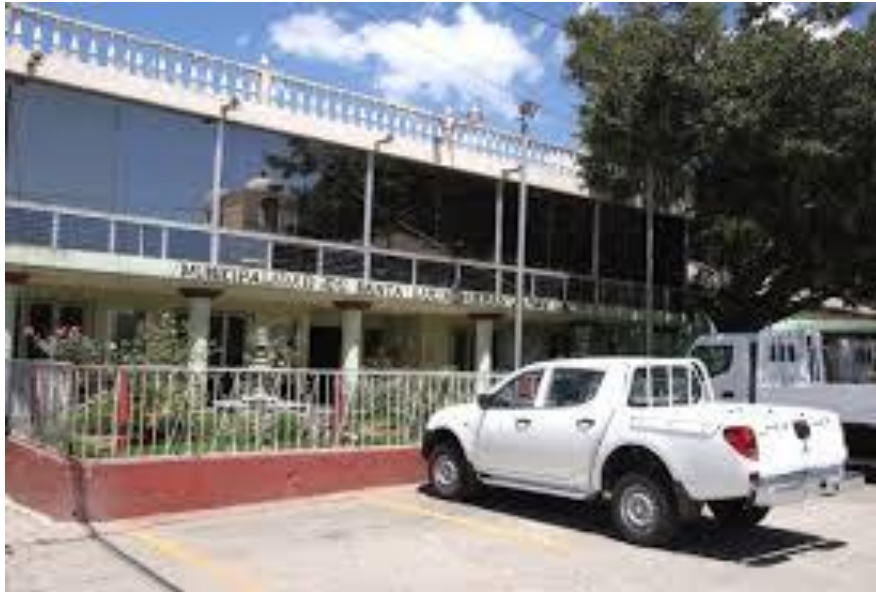
Figura 60. Edificio de la Municipalidad de Santa Lucía Milpas Altas
