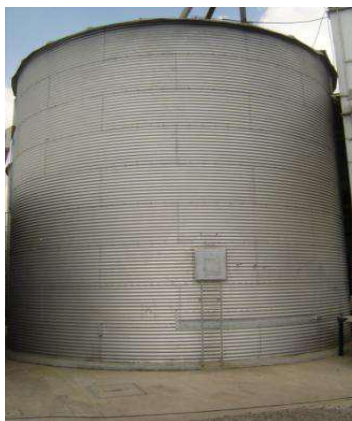
Silos de almacenaje del grano
